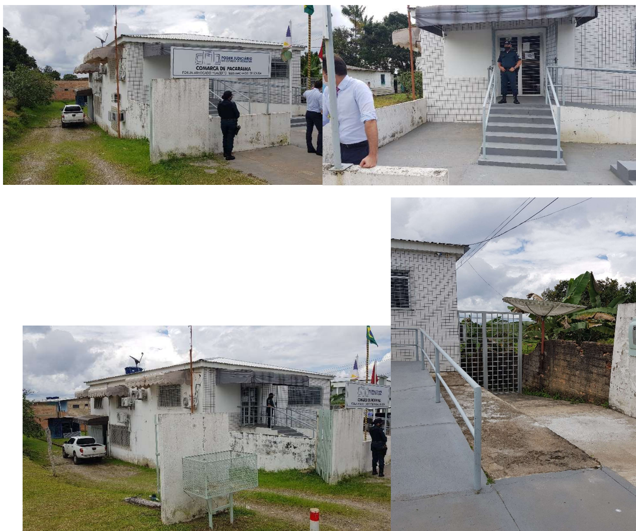
Figura 01 – Imagens da fachada principal, onde a rampa de acesso a PCDs será redirecionada, a parte frontal que receberá a grade metálica, o acesso de veículos na lateral esquerda e o acesso existente da lateral direita da edificação.
