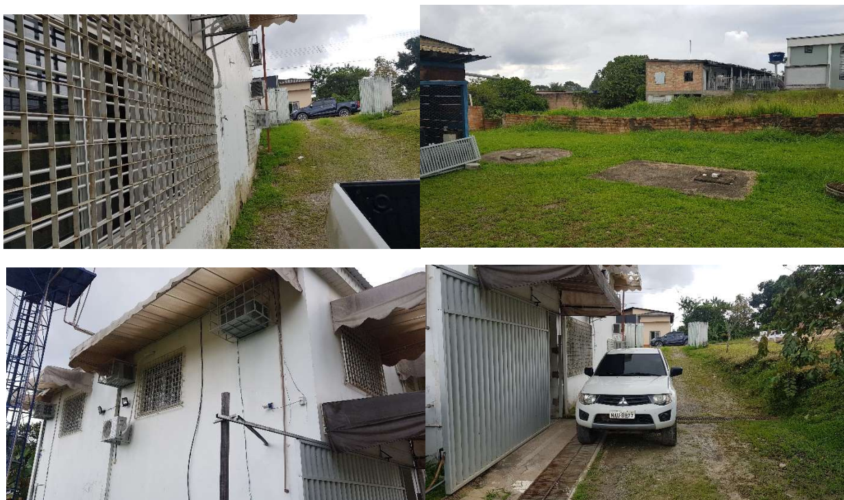
Figura 08 – O acesso lateral para a parte posterior do terreno, mostrando as janelas com grades de segurança, a parte posterior da área, mostrando o muro lateral direito, que necessita de reparo e ampliação. Na sequencia vista externa da sala do Juiz (futura sala do Promotor de Justiça e o acesso lateral, que necessita de colocação de brita nº 0 ou 1, para melhorar a circulação de pessoas, mantendo a permeabilização do solo.
